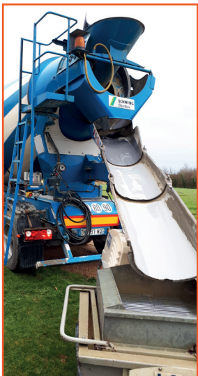
Versement du mélange de la toupie dans la cuve de la pompe
