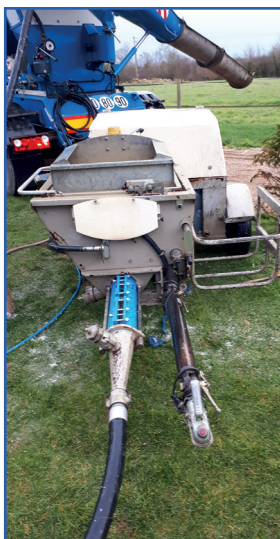
Coulage à la pompe
