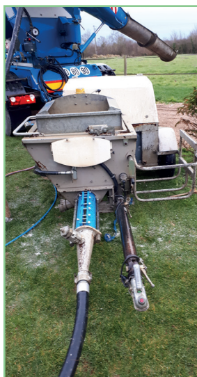
Coulage à la pompe à chape
