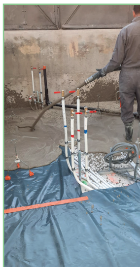
Coulage à la pompe à rotor
