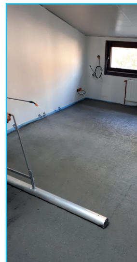
Mise à niveau à la barre à débuller (pour la formule fluide)
