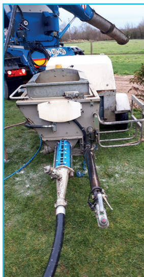
Coulage à la pompe à chape
