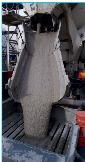
Versement du mélange dans la cuve de la pompe
