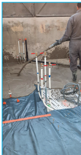
Coulage à la pompe à rotor
