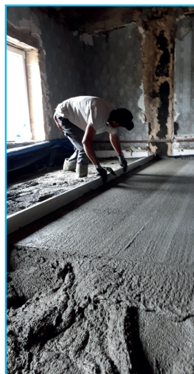
Mise à niveau à la règle de maçon
