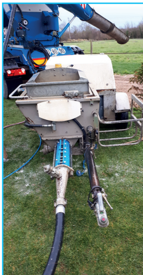
Coulage à la pompe
