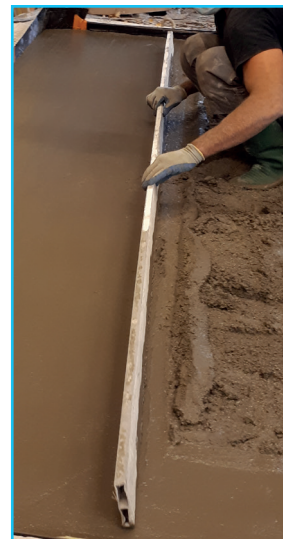
Finition à la règle de maçon
