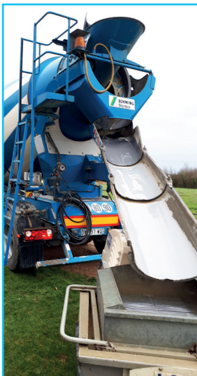
Versement du mélange de la toupie dans la cuve de la pompe
