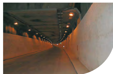
"CIRCONVALLAZIONE NORD" REVÊTEMENT DE LA GALERIE - ROME - ITALIE
