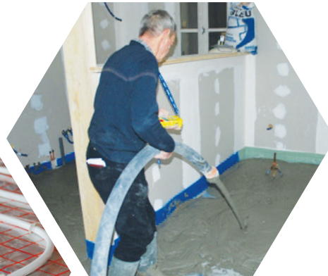
Ravoirage allégé POLITERM® comme support de plancher chauffant.
