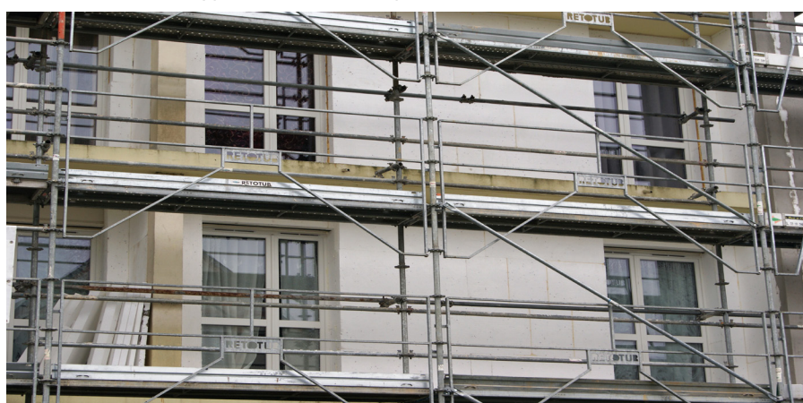
Pose du système EDIL-Therm® PSE
