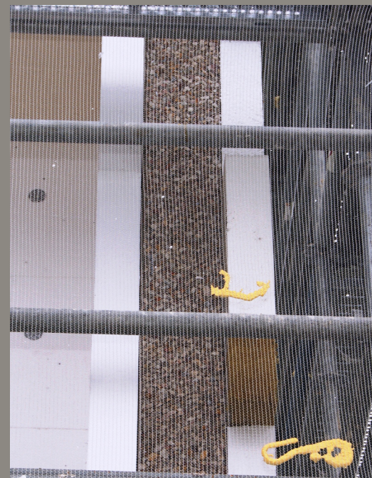
Pose EDIL-Therm® PSE sur construction béton préfabriquée avec gravillons
